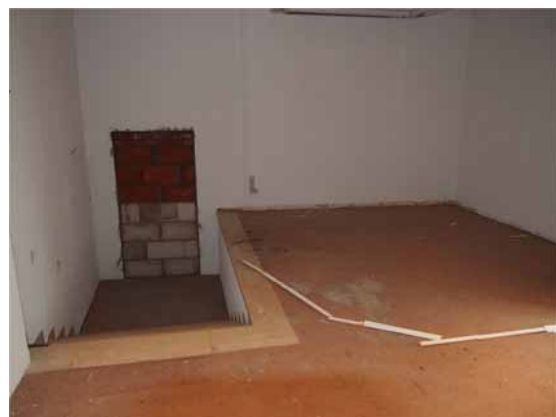
Zustand des Raumes vor der Renovierung und Beginn der Bauarbeiten mit Schließung des Durchgangs zum vorderen Gebäudeteil, späterer Standort der Theke
